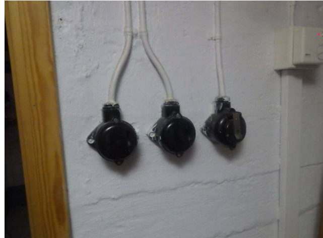
67. Sähköasennukset on alkuperäisiä monin osin
