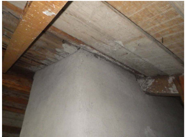
39. Savupiipun läpivienti, ei vuotojälkiä
