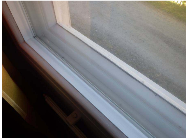
22. Asuinkerroksen ikkunoihin on lisätty ikkunalasi puitteiden väliin
