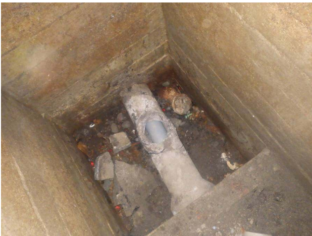
64. Alkuperäisen betonisen pohjaviemärin sisään on asennettu muoviviemäri
