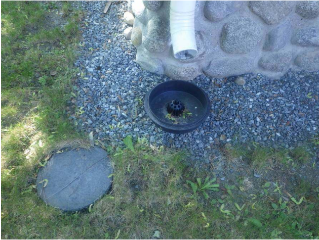
14. Kattovesien ohjausta ja salaojan tarkastuskaivoa
