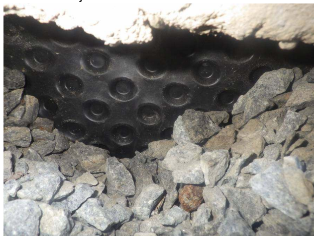
4. Patolevyä perusmuuria vasten
